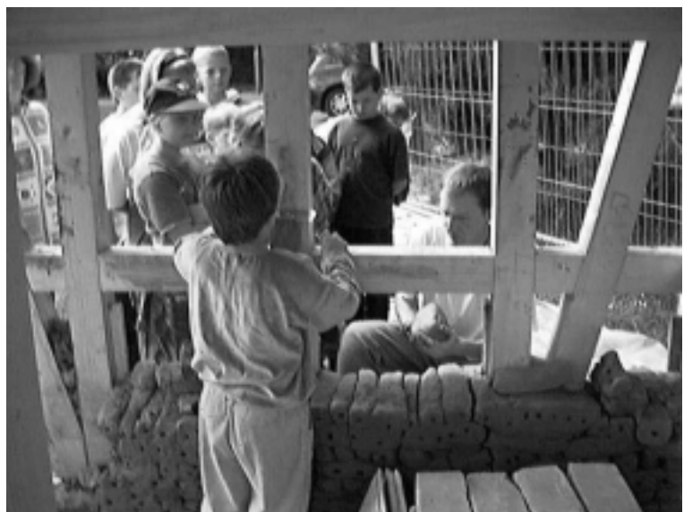
Beim Bau des Lehmhauses auf dem Spielplatz Stolzwiese
